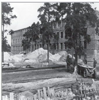
Siedziba IŁ w Warszawie Miedzeszynie przy ul. Szachowej 1. W budowie (1956 r.)
