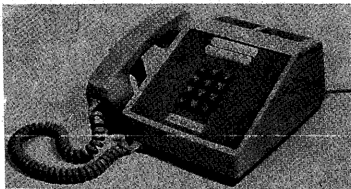
Rys. 11. USA. Aparat telefoniczny typu TOUCH-TONE CARD DIALER, wprowadzony w 1963 r.
