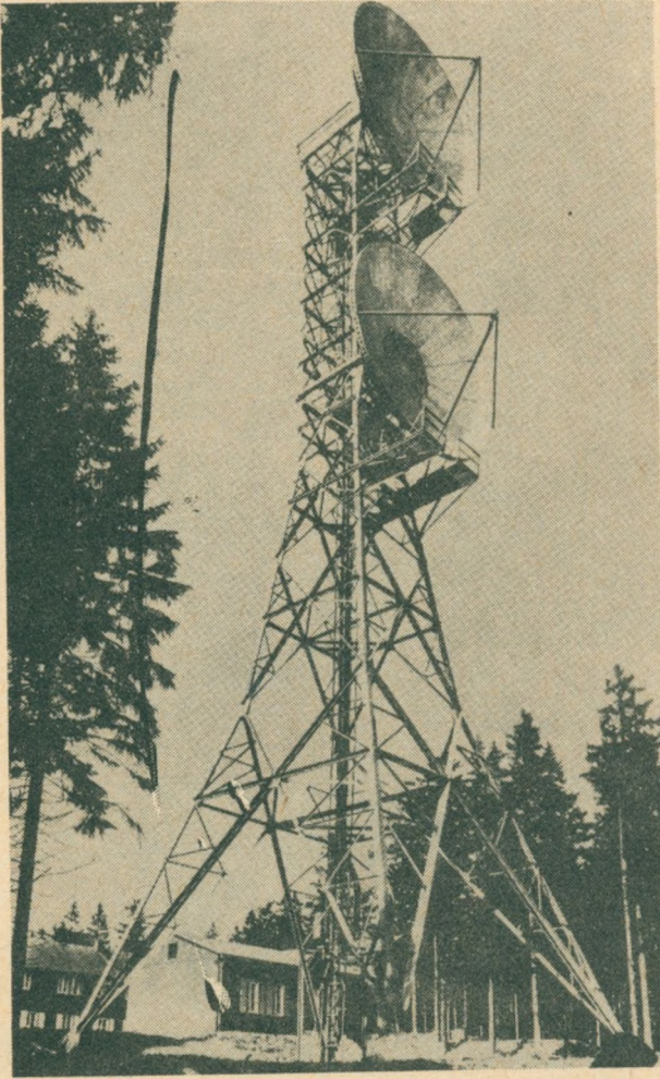
Rys. 55. Wieża H = 45 m w górach Harzu z antenami o średnicy 10 m
