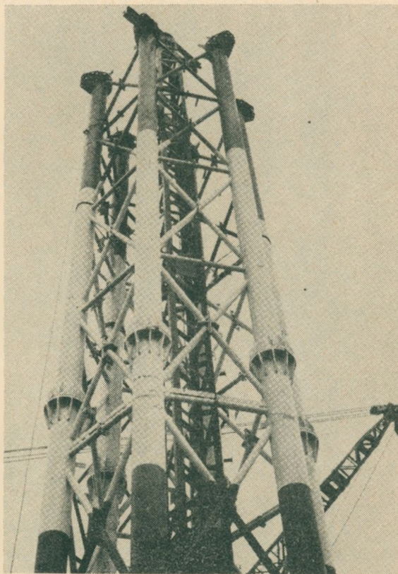
Rys. 54. Montaż dźwigara kratowego H = 67,5 m na wieży w Hamburgu
