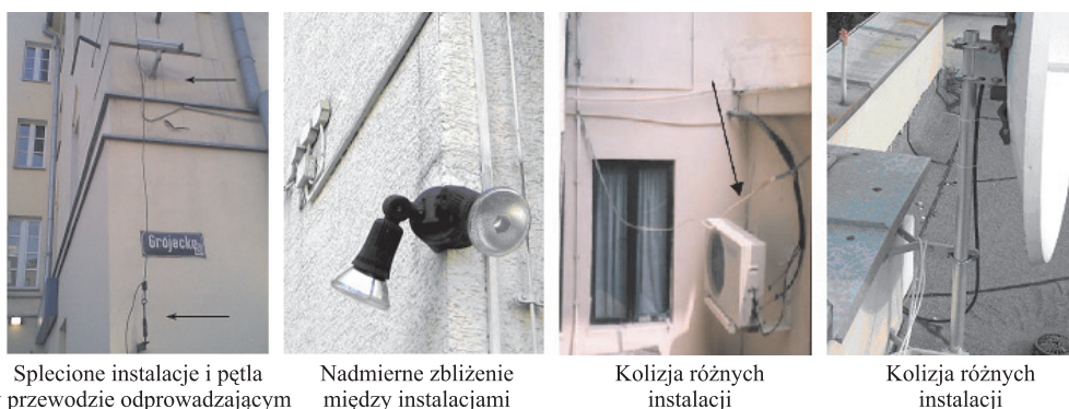
Rys. 4. Przykłady braku koordynacji urządzeń piorunochronnych z innymi instalacjami
