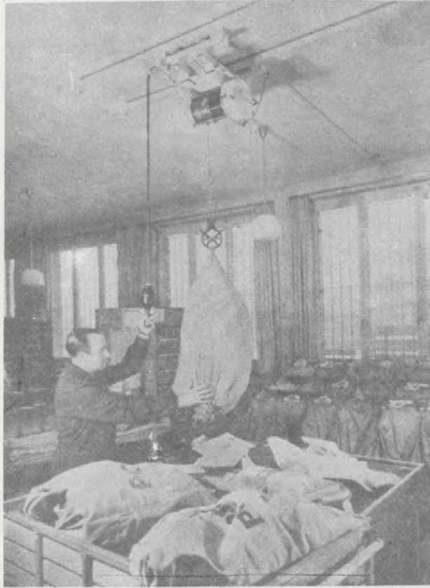
Rys. 16. Stanowisko opróżniania worków pocztowych za pomocą wciągnika elektrycznego
