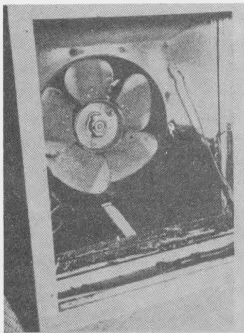
Rys. 11. Nagromadzony pył we wnętrzu wentylatora
