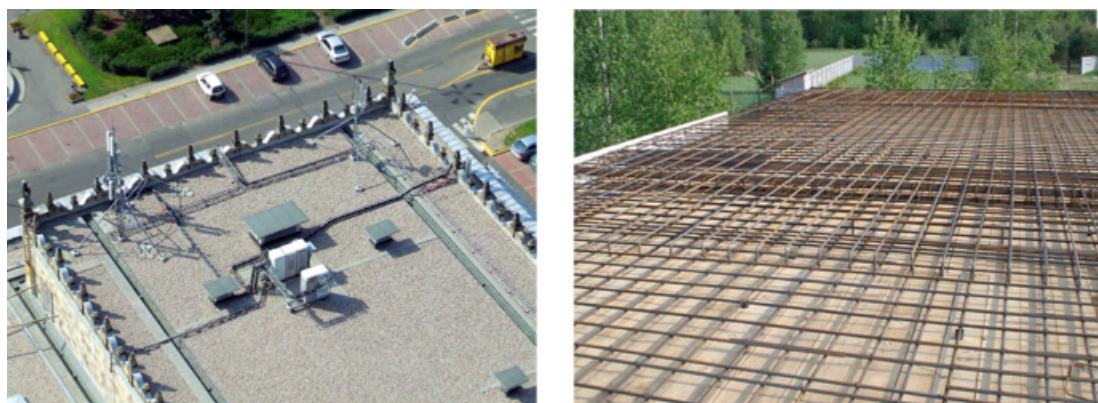
Rys. 2. Przykład anten stacji bazowych na dachu budynku (lewa strona) oraz przykład typowego stropu zbrojonego w trakcie budowy (prawa strona). Metalowe pręty zbrojenia mogą działać jak przypadkowe anteny bierne, w których mogą się indukować prądy wielkiej częstotliwości z anten nadawczych umieszczonych bezpośrednio nad nimi. Pod wpływem korozji, ich styki mogą działać jak nieliniowe rezystancje i generować produkty intermodulacji. Takie zjawiska występować mogą na także połączeniach blach dachowych, siatek ogrodzeniowych itp. (źródło: Internet)
