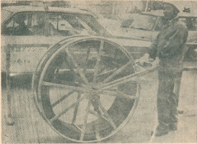
Rys. 2. Przetaczanie bębna z rurą
