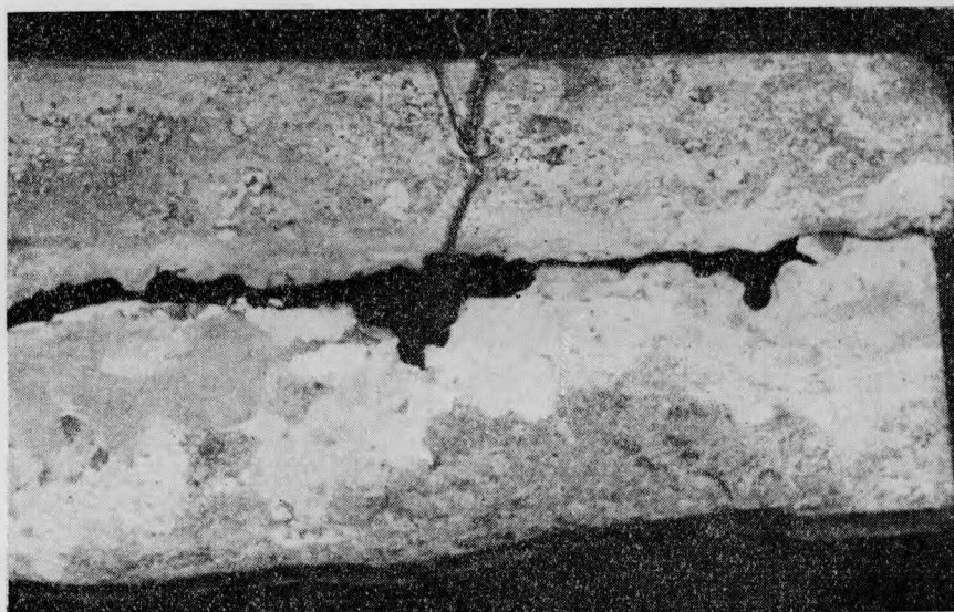
Rys. 4. Powłoka kabla TKM 600 × 2 ułożonego w kanalizacji (tabl. 4)
